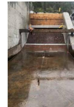
Der Entsander im Bereich Zilfuri wurde saniert. Im Mai 2024 wurde die Schussrinne durch das Einbringen von Stahlplatten erneuert.
